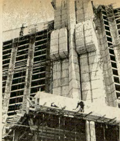
En un año se levantó la estructura.
