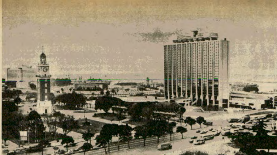
Este fotomontaje muestra cómo será el hotel cuando terminen las obras.
